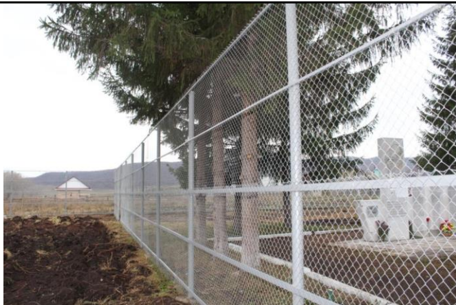
8. Ограждение спортивной площадки, 11.10.2017 г. РБ Гафурийский район, с. Юлуково, ул. М. Гафури, 2а
