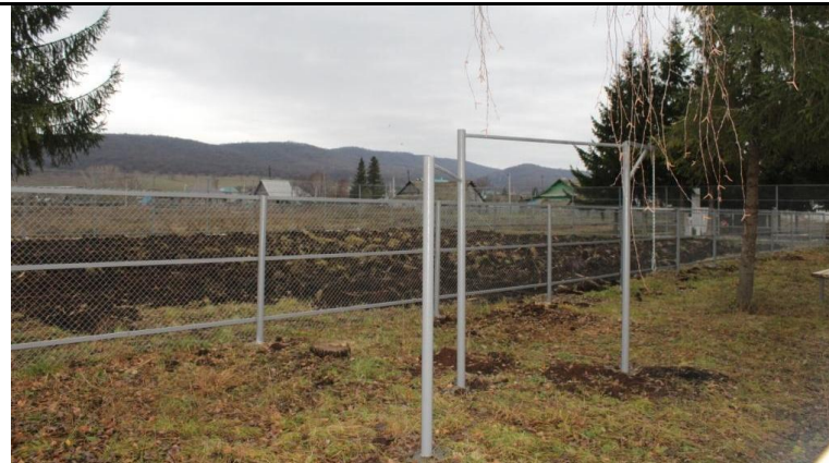
10. Благоустройство территории, турник, скамейки. 11.10.2017 г. Стадия благоустройства. РБ Гафурийский район, с. Юлуково, ул. М. Гафури, 2а
