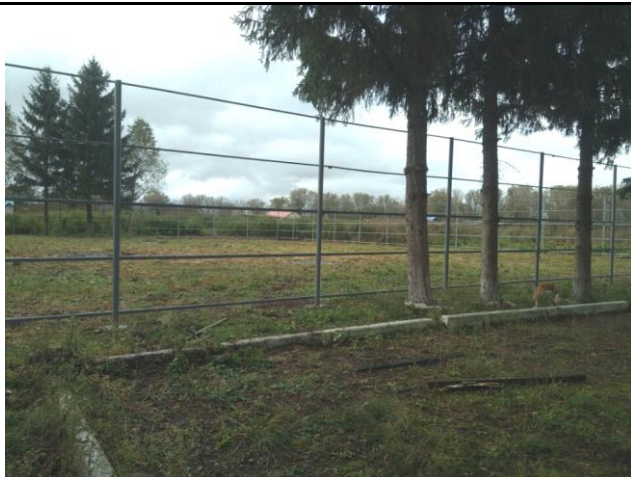
8. Ограждение спортивной площадки, 1.10.2017 г. РБ Гафурийский район, с. Юлуково, ул. М. Гафури, 2а
