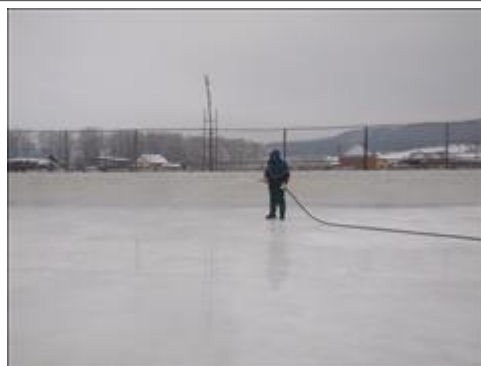
Заливка катка Заливка катка. Следующий слой.
