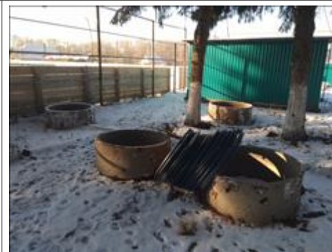
ПНД трубы, ж/б кольца Приобретены водяные ПНД трубы, водяной шланг, ж/б кольца подключить спортивную площадку к центральной системе водоснабжения села.
