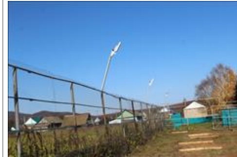
Светильники Светильники уличного освещения мощностью по 30 Вт 6 штук установлены по периметру спортивной площадки
