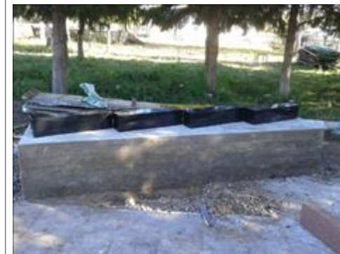
6. Закладка фундамента под обелиск, 15.09.2017 г. РБ Гафурийский район, с. Юлуково, ул. М. Гафури, 2а
